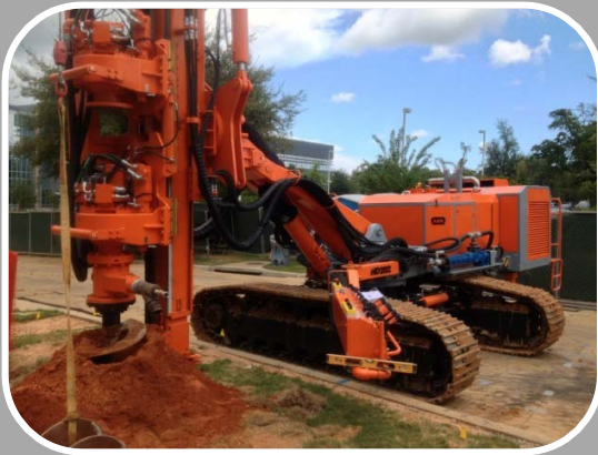
USA - Augering Ø610 mm
