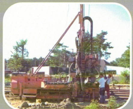
Germany (Deutschland) - Dry Drilling, With Casing Rotary Table (Trockenbohren-mit-Drehtisch)
