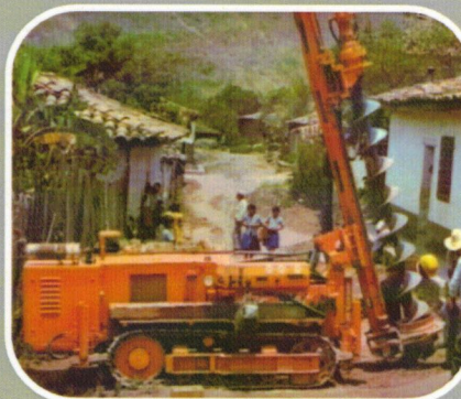
Honduras - Augering (Trockenbohren mit Schnecke)
