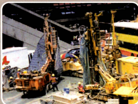
Hong Kong - Micro Pile \phi 273.0\text{mm} Hong Kong - Mikropfahl \phi 273\text{mm}
